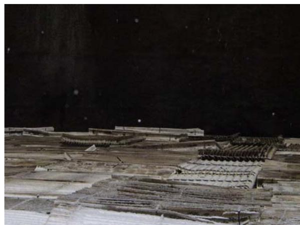
Рис. 2. Водоуловитель из элементов ПВХ полуовална
