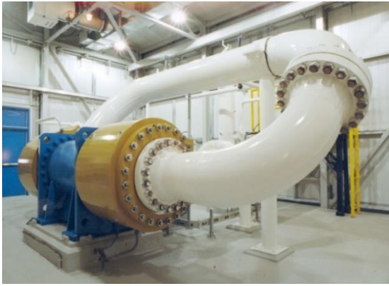
Рис. 1. Общий вид современных герметичных мотор-компрессорных технологических установок для КС МГ
