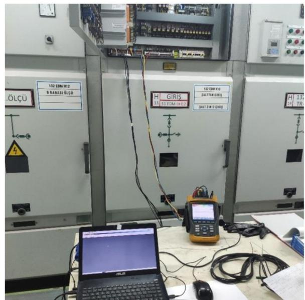
Рис. 4. Фотография измерительного комплекса, применяемого при исследованиях на действующем оборудовании ММК Metalurji
